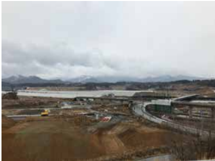
嵩上げ工事が進む気仙沼市本吉町津谷川河口付近 (2019.03)
