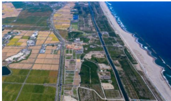
上空から見た荒浜地区とかさ上げ道路
